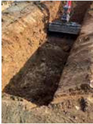
Grabenbreite 2m Grabentiefe 1,5 bis 1,8m
